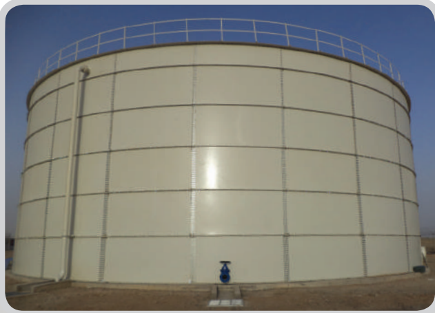
Silindirik Depo Sıvı Membran Uygulaması
